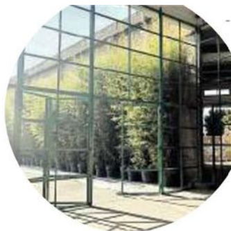
I lavori di recupero in un deposito dismesso
